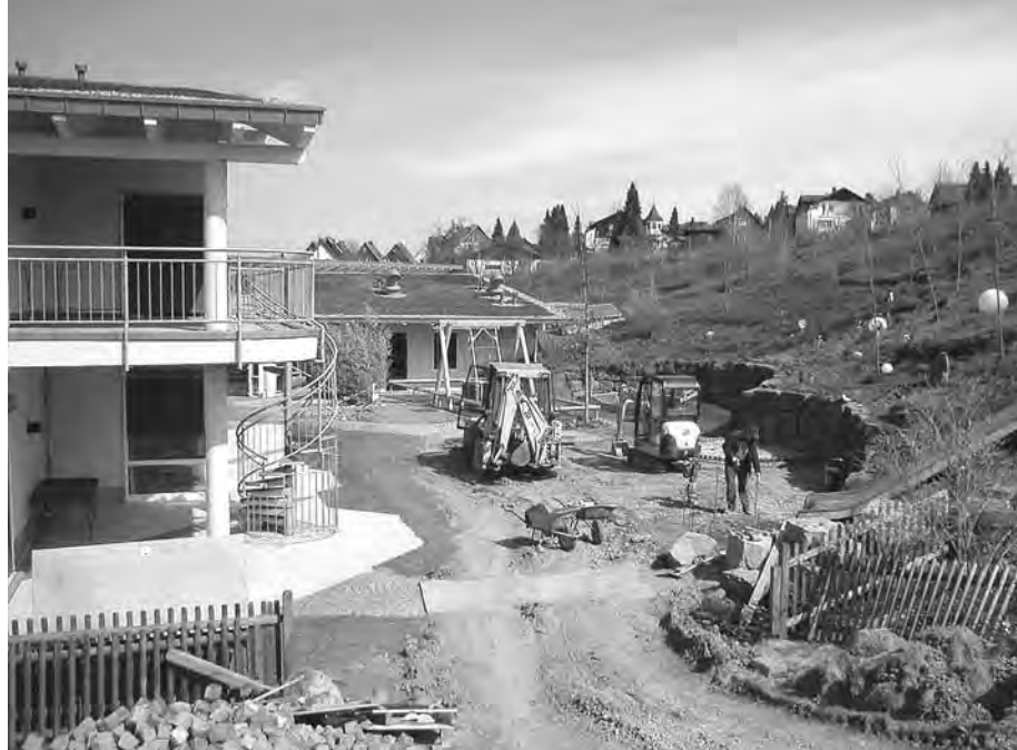
Andererseits große Bedenken... Große Bedenken gab es bei Mitarbeitern und Eltern, als die Bagger anrückten.
